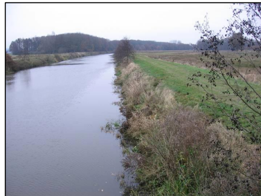
Regge na kanalisatie, geheel gestuwd, lijkt op een kanaal, lengte circa 50 km
